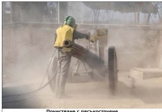
Почистване с пясъкоструене
